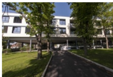
Rehabilitační klinika Malvazinky
