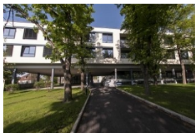
Rehabilitační klinika Malvazinky
